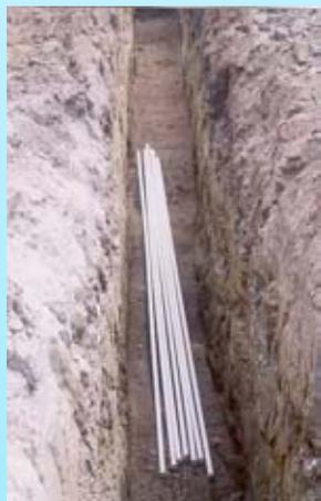
Sistema de Drenagem Interna da B.S. Colada ao Fundo do *Cut Off*
